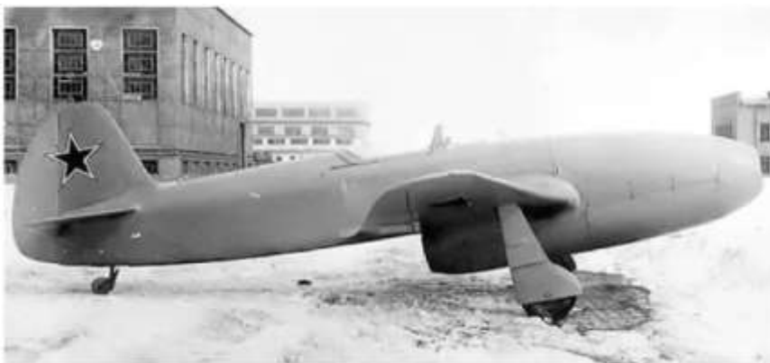
Fotografie vpravo jasně ukazuje ocelový potah podél trupu, chránící jej před horkými výfukovými plyny, a celooceľové ostruhové kolo.
